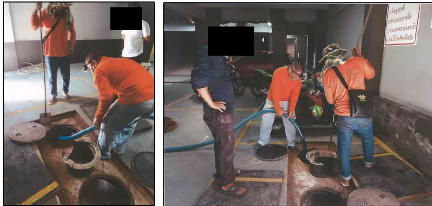
รูปที่ 3-14 การสูบน้ำส่วนเกินจากระบบบำบัดน้ำเสีย
