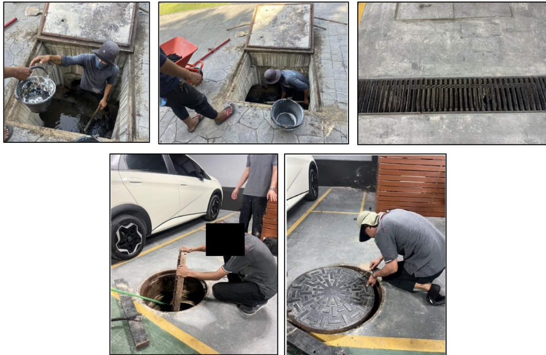
รูปที่ 3-4 การตรวจสอบดูแลรักษา ทำความสะอาดท่อระบายน้ำ และรางระบายน้ำของโครงการ
